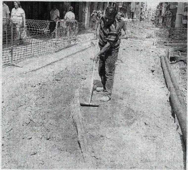
OBRAS. Se recuperará en uno de sus tramos. / ENRIQUE
